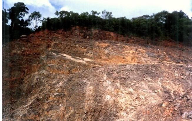
Vista de la zona central y zona norte de la cantera, obsérvese la diferencia en buzamiento del talud, más empinado en la zona central, por el cambio en la orientación de la cara del talud.
